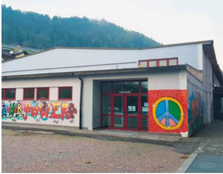
Die alte Turnhalle der Mittelschule: Außenansicht
